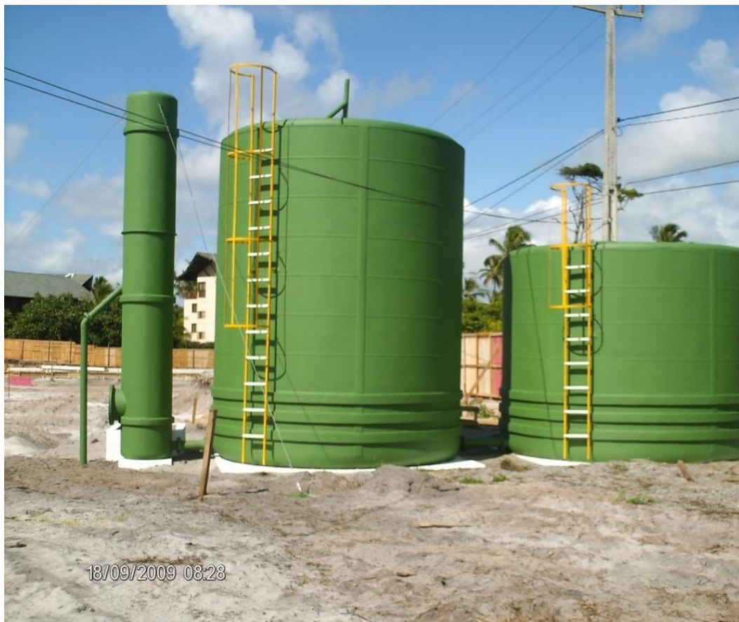
Figura 5 – Reator de manta de lodo em construção
