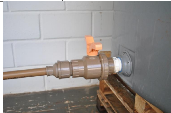
Figura 10 – Tubulação de diâmetro 25 mm com furos de 2,5 mm. Figura 11 – Detalhes da caixa de água, válvula e tubulação de 25 mm.
