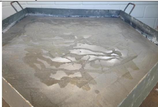
Figura 15 – Óleo lubrificante recém disposto sobre a superfície concretada.
