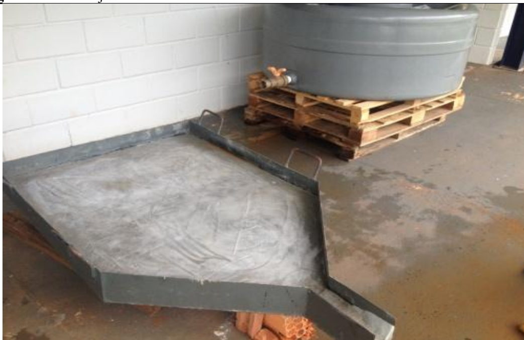
Figura 17 – Bandeja concretada untada com óleo lubrificante.
