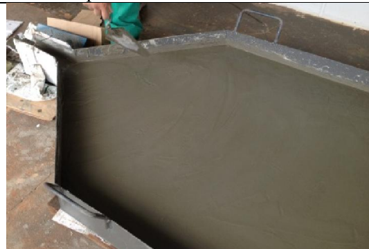
Figura 6 – Implantação e nivelamento do concreto queimado.
