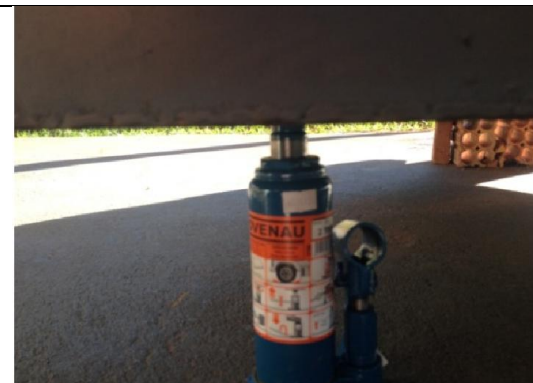
Figura 8 – Macaco hidráulico para utilizado na calibração da inclinação da bandeja.
