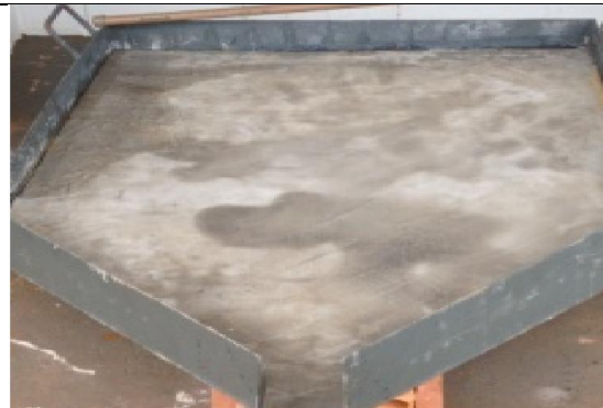
Figura 16 – Bandeja concretada com manchas oleosas secas.
