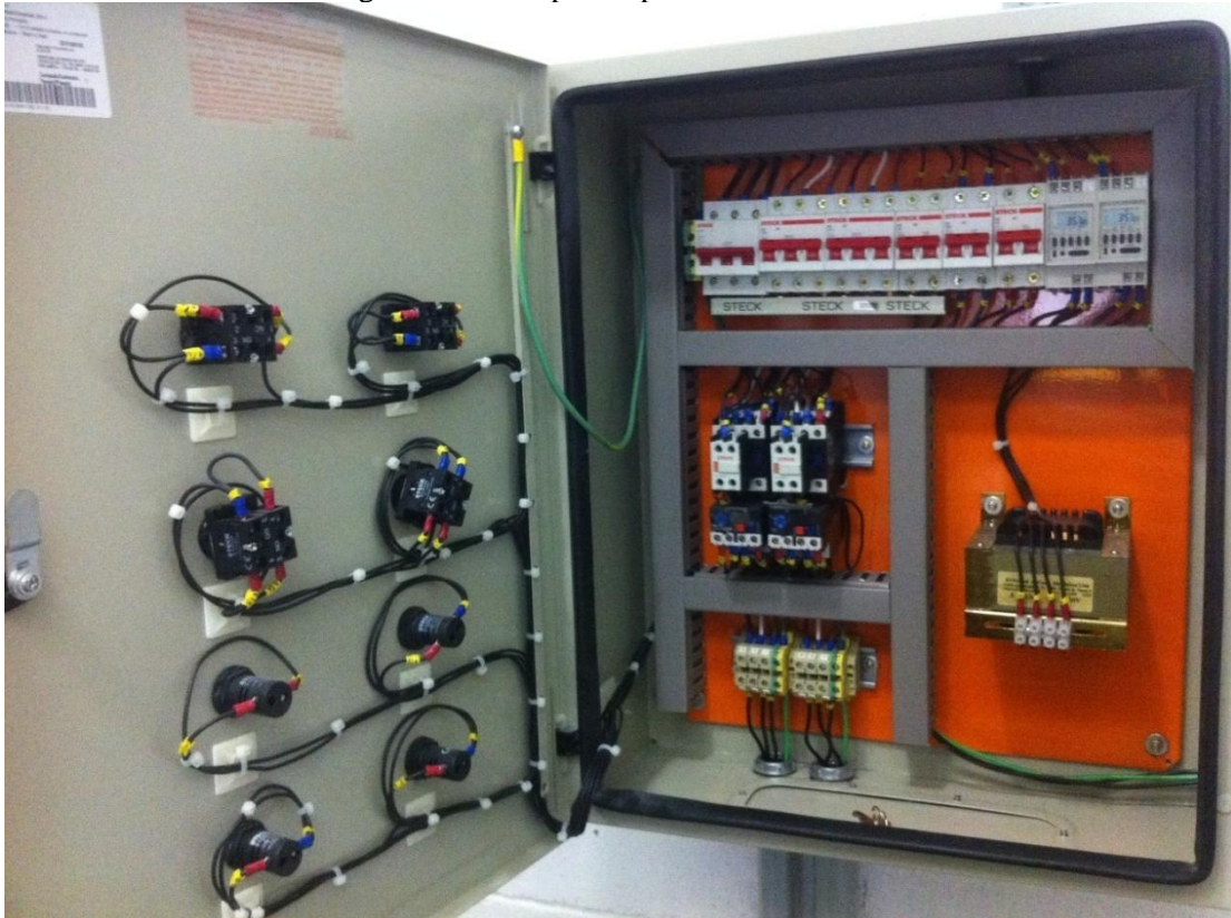
Figura 14: Exemplo de painel de comandos elétricos
