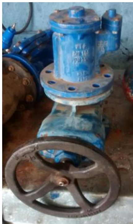
Figura 6 – Válvula de Alívio.
