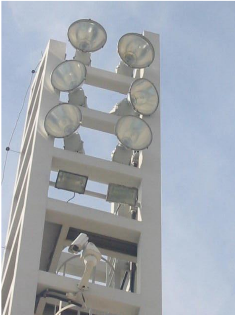
Figura 2 – Torres de iluminação de pátio de aeronaves
