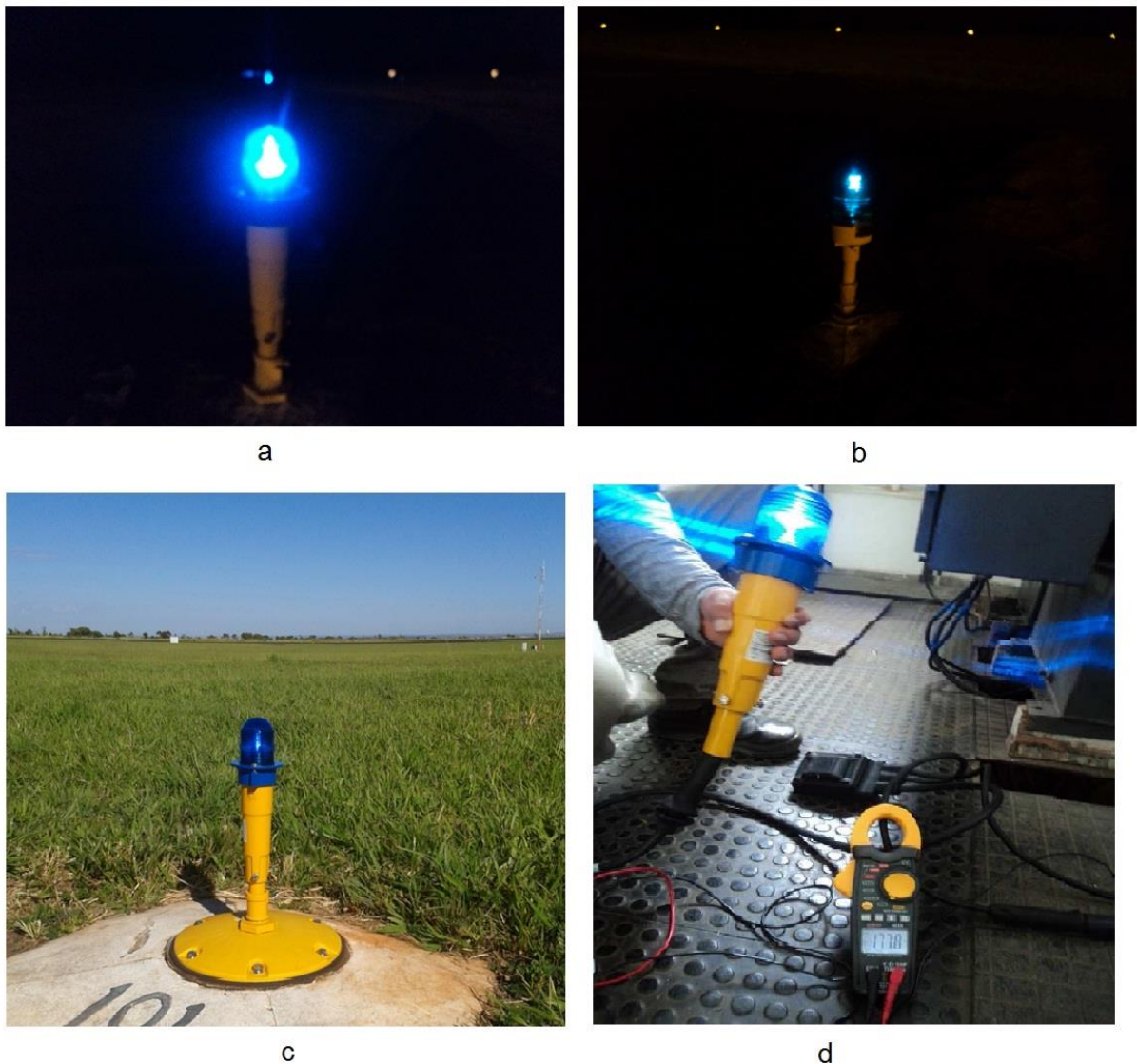
Figura 14 – Balizamento LED do Aeroporto A
