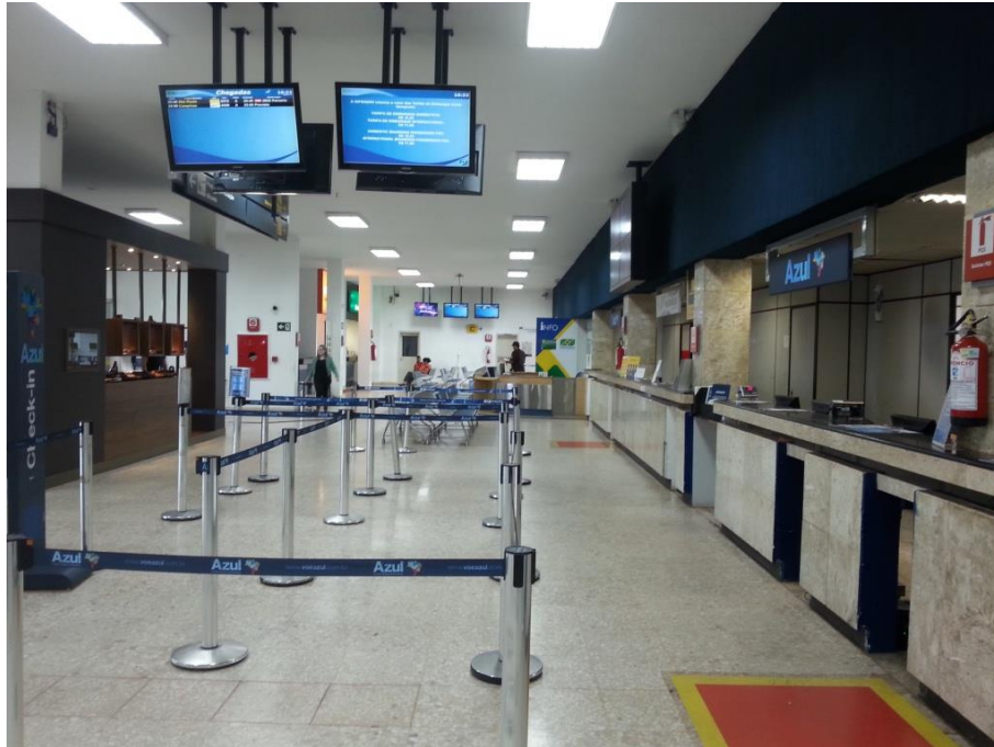
Figura 1 - Iluminação de terminal de passageiros
