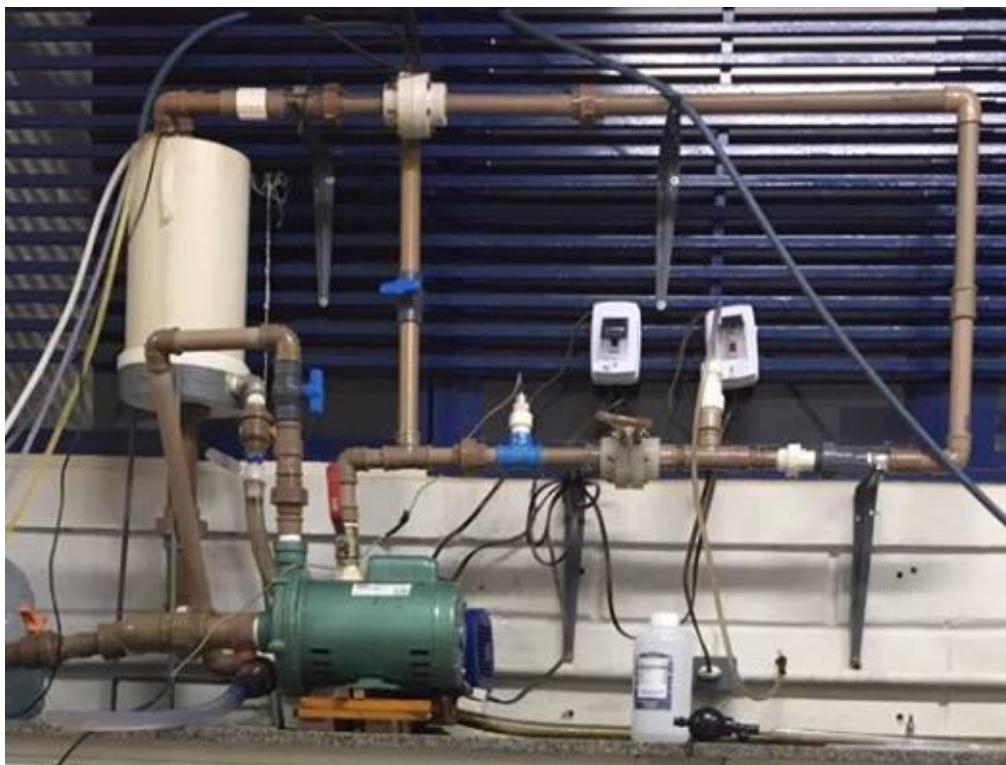
Figura 18 – Aparato de cavitação em funcionamento
