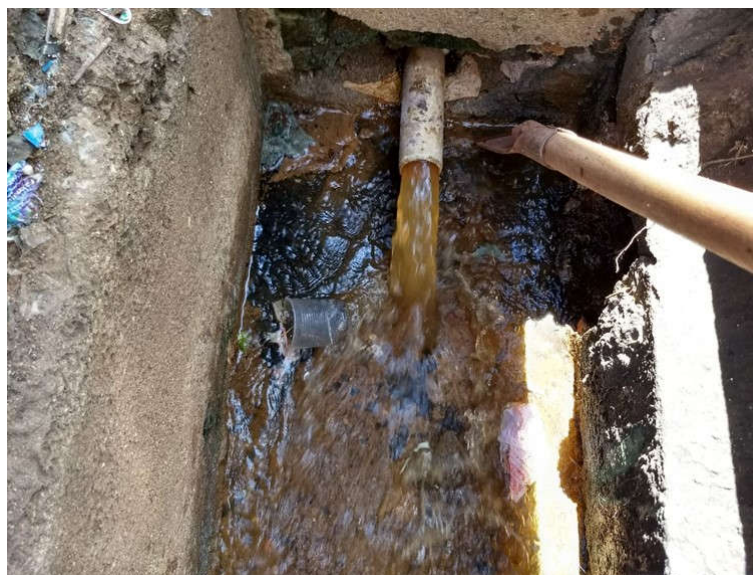
Figura 27 – Descarga em rede do sistema de distribuição de água.
