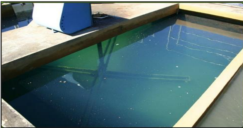
Figura 5 Tanque de floculação com agitadores de baixa velocidade
