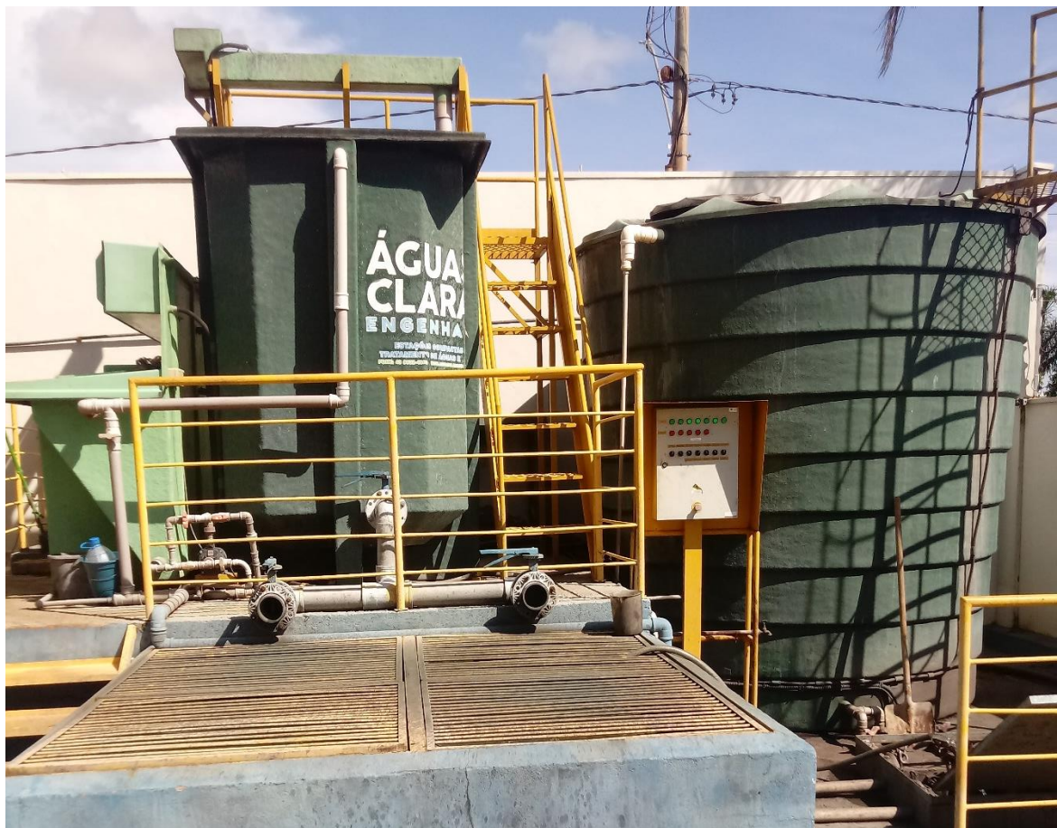
Figura 7 - Fotografia da estação de tratamento de efluente da empresa Electric Ink LTDA.
