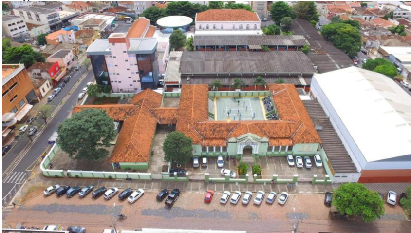
Figura 8 - Vista de cima da Escola Estadual Minas Gerais em Uberaba-MG
