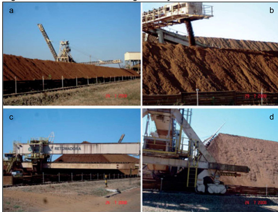
Figura 13 - Processo de homogeneização do minério
