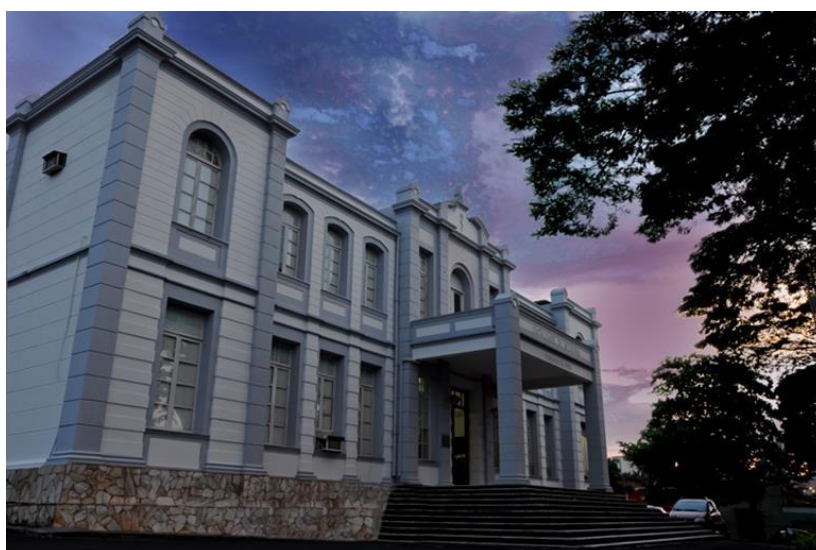
Figura 3 – Fachada do campus I.
