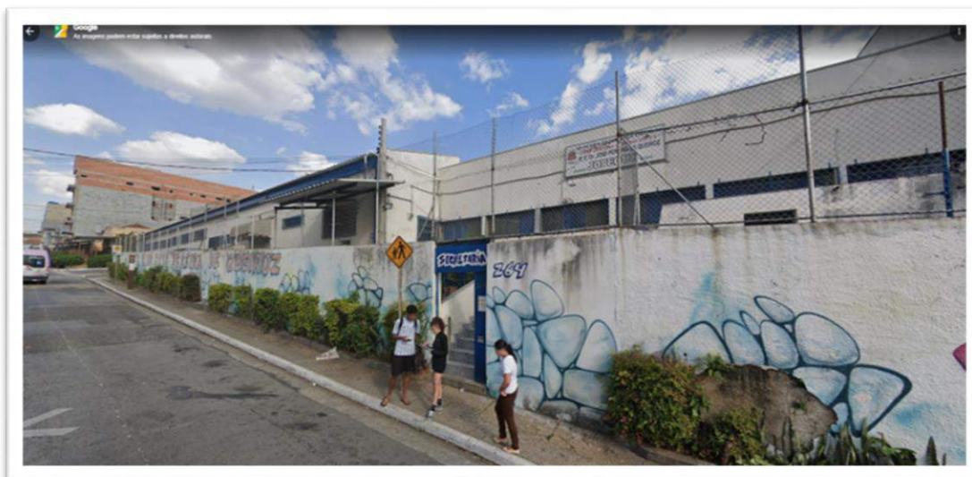
Figura 2 – Fachada da Escola Estadual Doutor José Pereira de Queiroz
