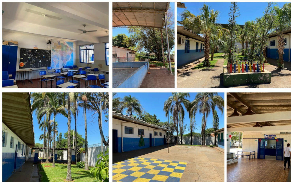
Figura 21 – Parte da estrutura física da Escola Municipal Vicente Alves Trindade.
