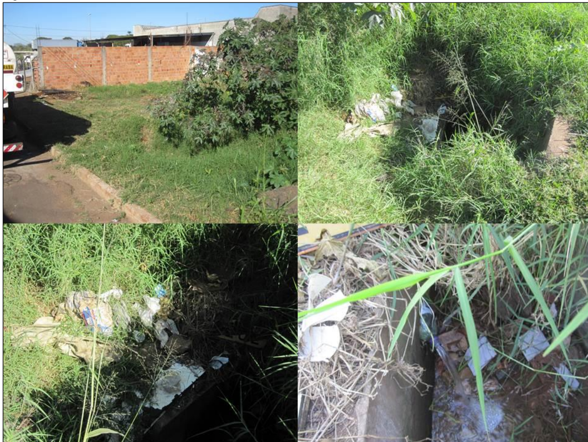
Figura 15 – Nascente São Cristóvão
